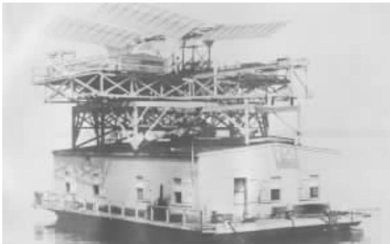
● 兰利研制的全尺寸飞机准备进行飞行试验
