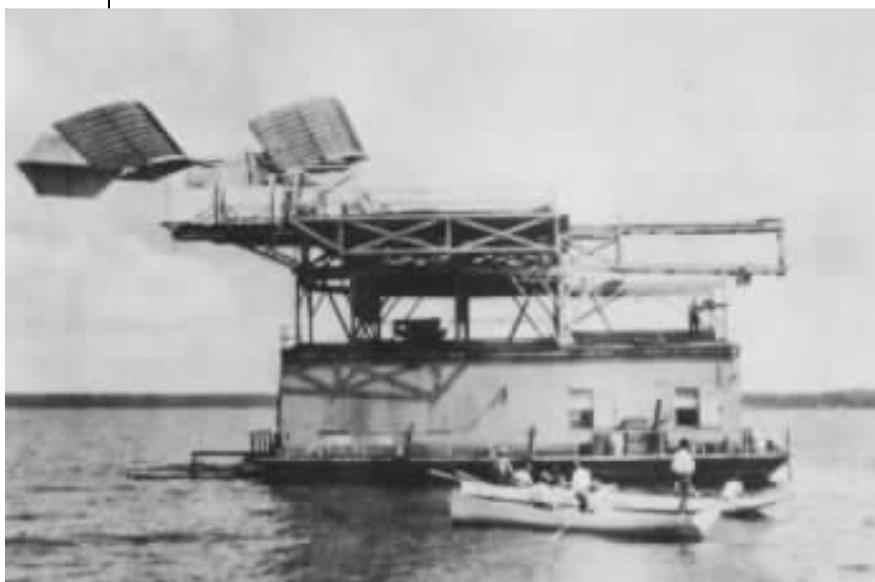
▶ 1903年10月7日和12月8日,美国航空先驱兰利试制的“空中旅行者”号飞机进行了两次试飞,由其助手曼利驾驶。由于起飞方式存在严重问题,两次均遭失败。两周后,莱特兄弟试飞成功第一架飞机,开创了航空新纪元。“空中旅行者”号飞机虽然未能取得成功,但它是莱特兄弟之前最接近成功的设计。
